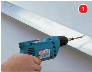
Befestigen der Aluminium-Abschluss-schiene
